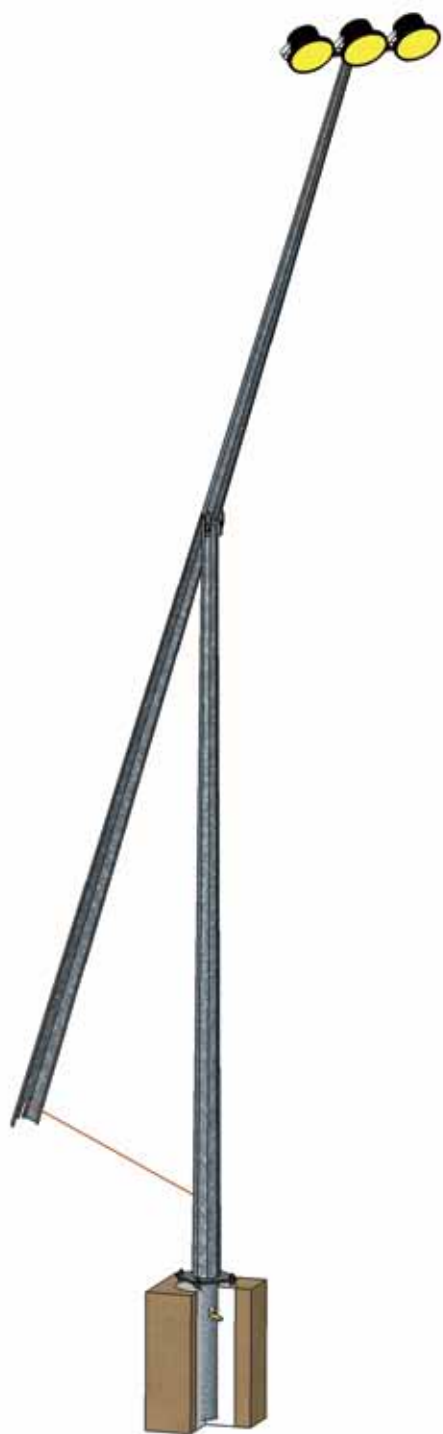
Установка опоры МТ на металлический фундамент.
