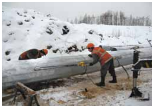
стягивание секций ствола
