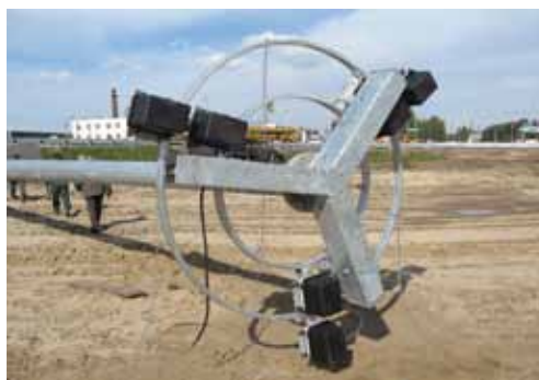
для первого спуска короны, временно крепятся 3 веревки или устанавливается груз
