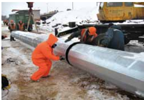
стыковка секций ствола мачты
