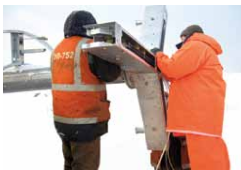
установка оголовка и короны
